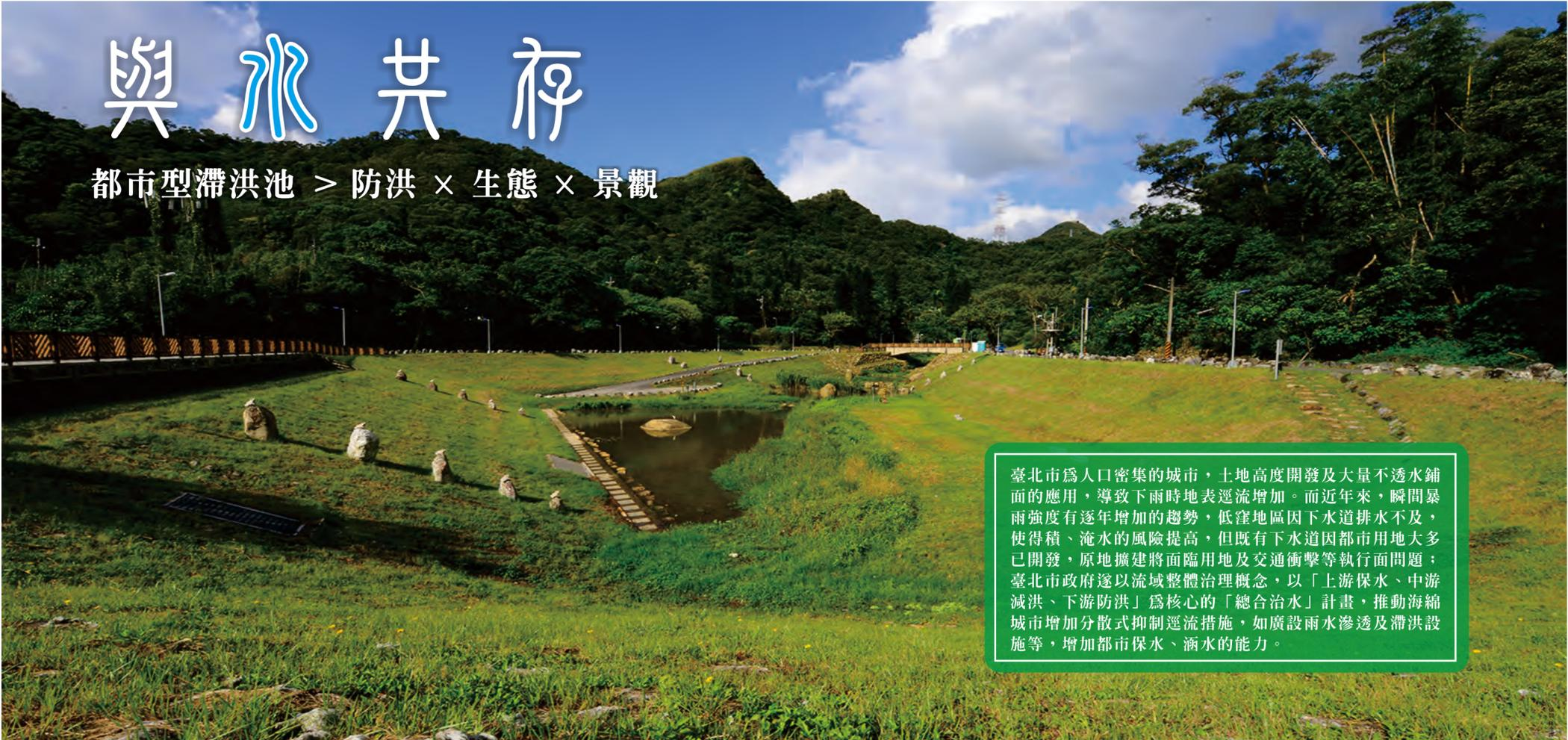
臺北市為人口密集的城市，土地高度開發及大量不透水鋪面的應用，導致下雨時地表逕流增加。而近年來，瞬間暴雨強度有逐年增加的趨勢，低窪地區因下水道排水不及，使得積、淹水的風險提高，但既有下水道因都市用地大多已開發，原地擴建將面臨用地及交通衝擊等執行面問題；臺北市政府遂以流域整體治理概念，以「上游保水、中游減洪、下游防洪」為核心的「總合治水」計畫，推動海綿城市增加分散式抑制逕流措施，如廣設雨水滲透及滯洪設施等，增加都市保水、涵水的功能。
